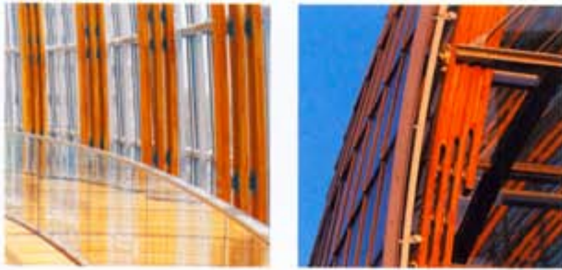
Verbindung der Holzlamellen mittels Gussteilen zu einer schubsteifen Koppelung
