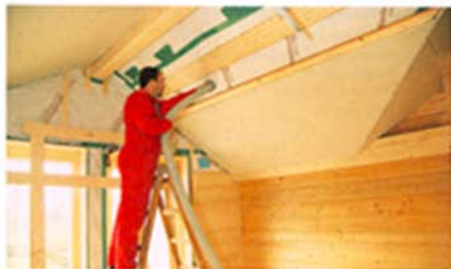
Die Dämmung wird vom Fachmann in die vorbereiteten Bauteile eingeblasen
