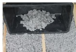
Der Dämmstoff wird dann in die Konstruktion geschüttet und mittels Rechen lückenlos in der Konstruktion verteilt.
