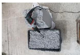
Mittels Bohrmaschine und Farbrührer wird der Dämmstoff zu einer losen flockigen Schüttung aufgelockert.
