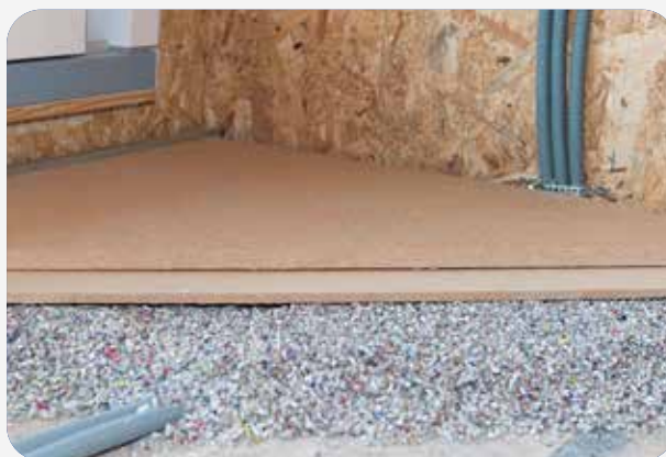
Pellet isolanti THERMOFLOC come granulato di cellulosa calpestabile
