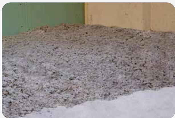
Gettata per pavimenti THERMOFLOC come isolamento di cellulosa non calpestabile
